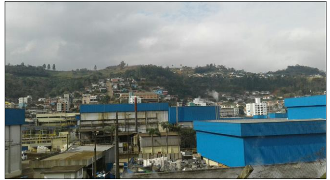
Figura 12.40. Indústria alimentícia instalada na cidade de Seara, distante 2,5 km da ADA (22S 369397m 6995277m UTM SIRGAS 2000).
