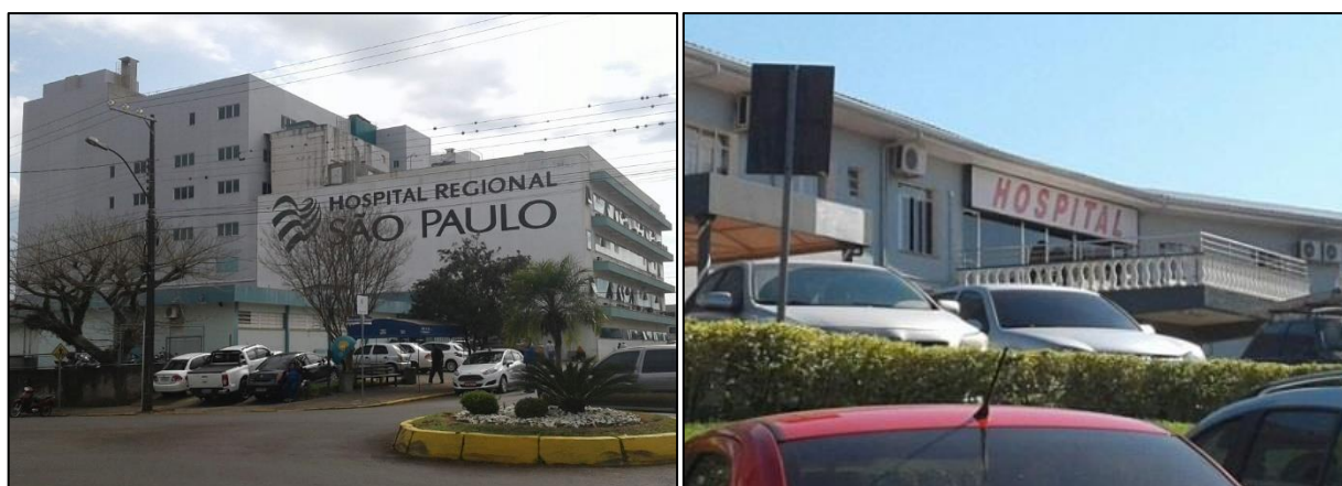
Figura 12.72. Hospital São Paulo, em Xanxerê (à esquerda) e Hospital de Pinhalzinho (à direita).
