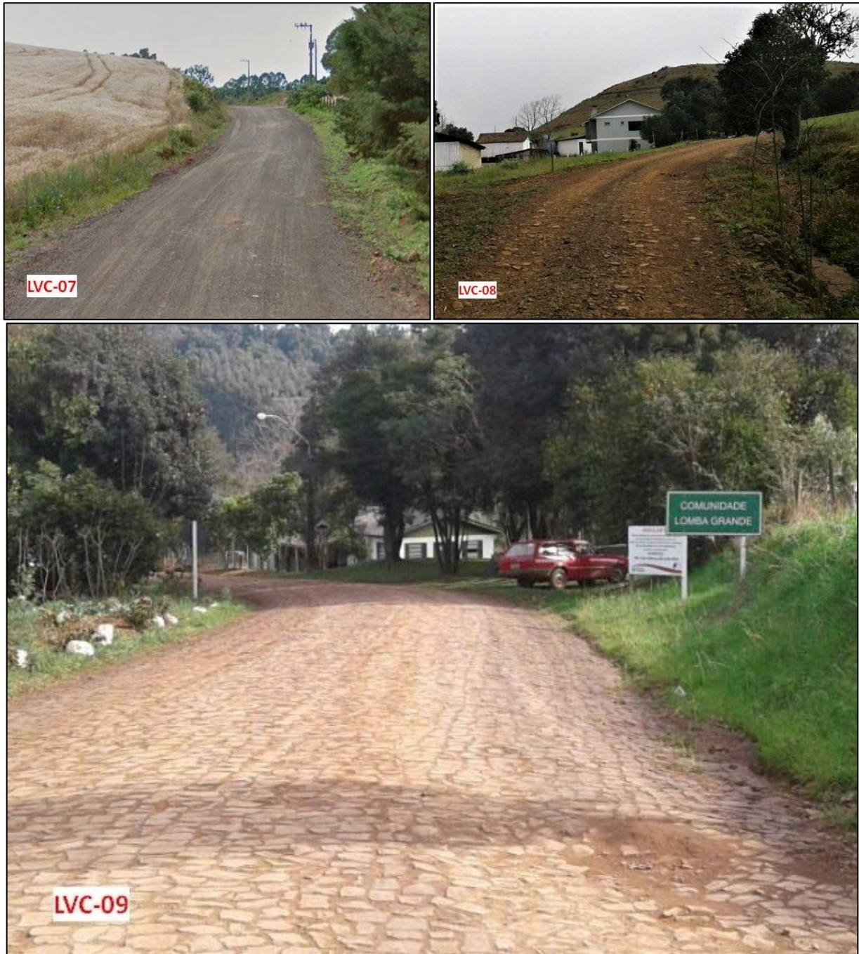
Figura 12.83. Amostra das condições viárias nos trechos dos levantamentos visuais 07 a 09.
