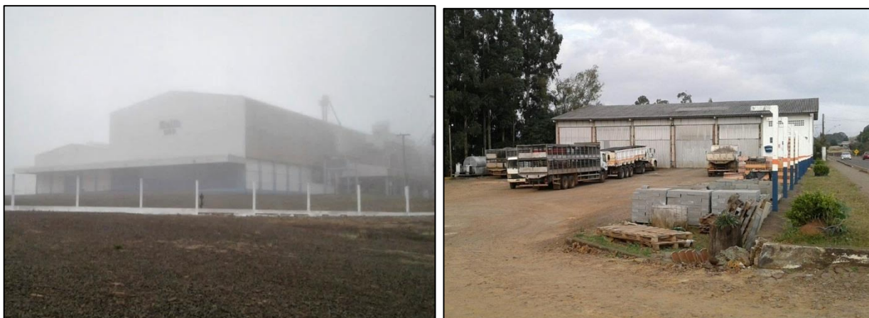
Figura 12.24. Em meio à neblina, a Unidade de Beneficiamento de Sementes em São Sebastião, município de Xanxerê (à esquerda); e empresa de transporte em Linha Palmeiras, município de Xavantina (à direita).
