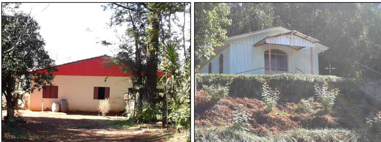
Figura 12.63. Residência em Linha Bela Vista (à esquerda) e Igreja em Linha Venci (à direita).
