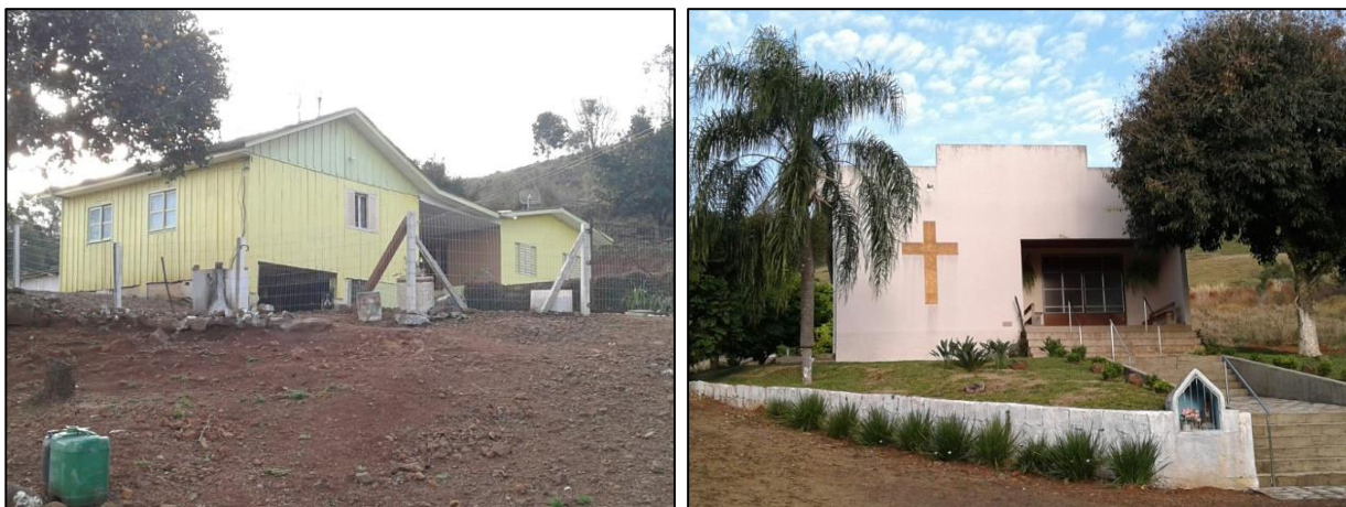
Figura 12.51. Residência em Linha Carlos Gomes (à esquerda) e Igreja em Linha Santa Terezinha (à direita).
