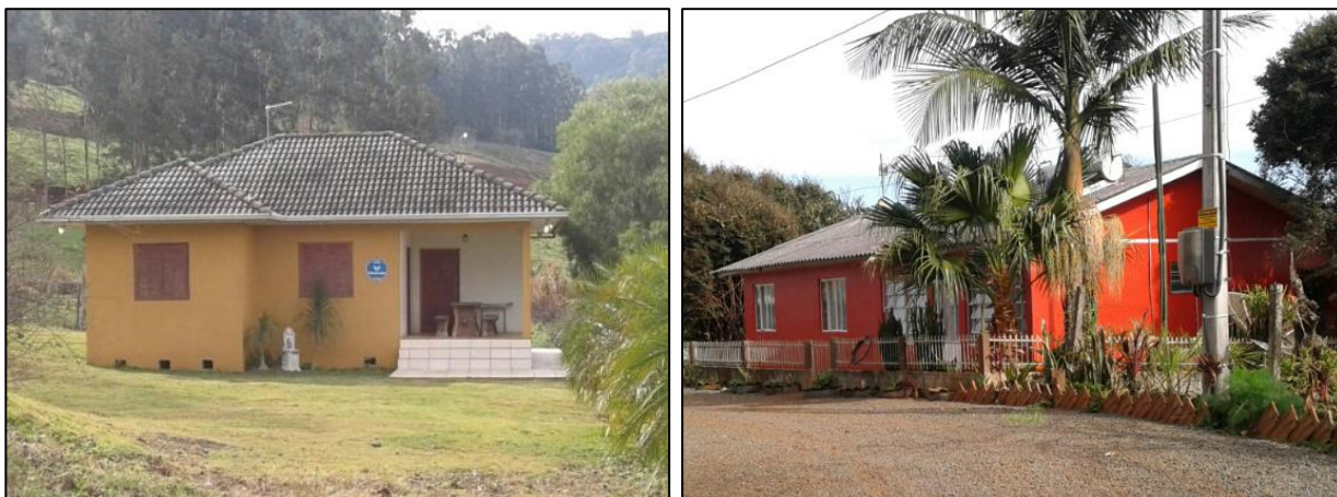
Figura 12.40. Residências unifamiliares de alvenaria, em Linha Carioca.
