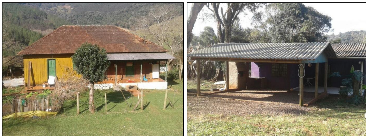
Figura 12.53. Residências unifamiliares na Linha Pedro Guerreiro.
