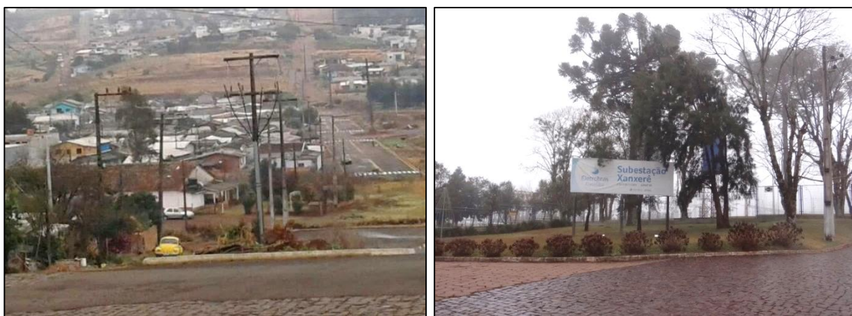
Figura 12.48. Bairro dos Esportes (à esquerda) e Subestação Xanxerê (à direita).
