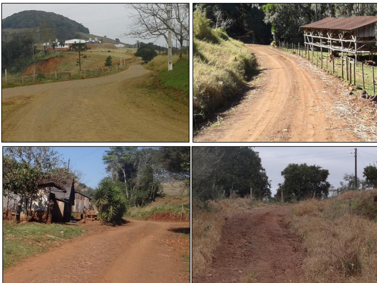
Figura 12.81. Amostra das condições viárias nas estradas vicinais no entorno da AID, representando condições boas (acima à esquerda), regulares (acima à direita), ruins (abaixo à esquerda) e péssimas (abaixo à direita).
