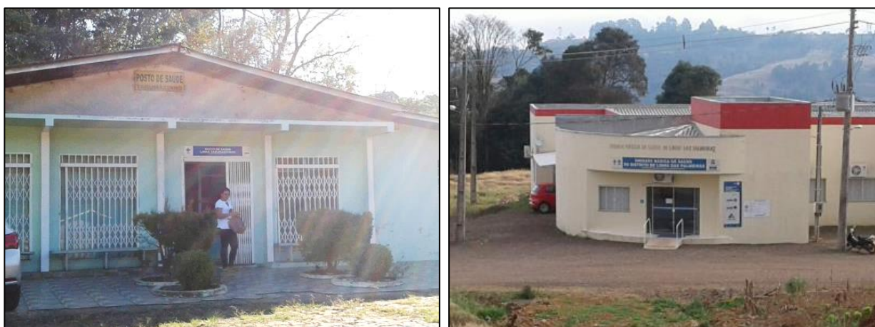
Figura 12.74. UBS Linha Tarumãzinho, em Águas Frias (à esquerda), e UBS Linha das Palmeiras (à direita), em Xavantina.
