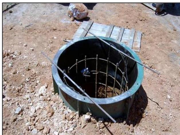
**Figura 7.4.** Vista de uma cava com a armadura de concreto colocada. Foto: CPFL
