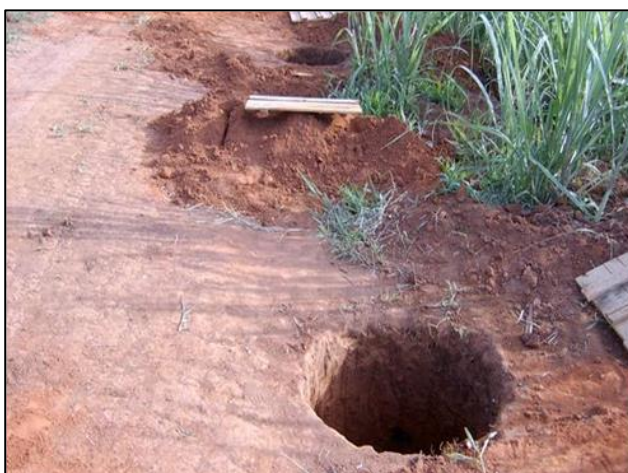
Figura 7.3. Vista de cavas abertas ilustrando sua pequena dimensão e pequeno volume de terra movimentado. Foto: CPFL
