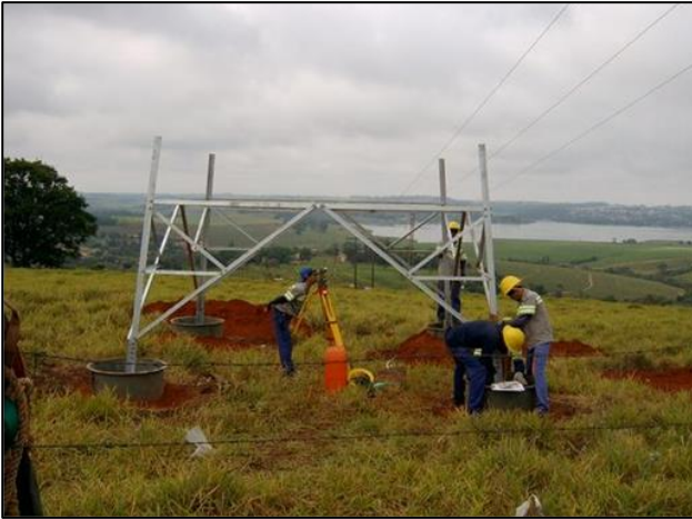
Figura 7.5. Vista da operação de nivelamento de uma base montada verificando a manutenção da vegetação existente no entorno da torre. Foto: CPFL
