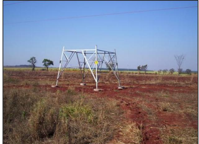
Figura 7.6. Vista de uma base montada e nivelada ilustrando o total aproveitamento do volume de terra retirado. Foto: CPFL
