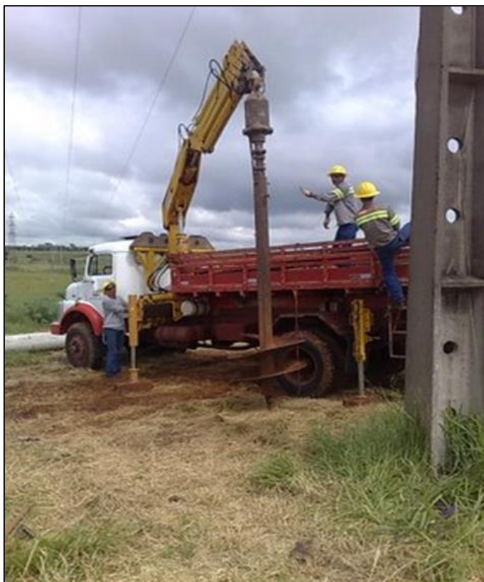
Figura 7.2. Abertura da cava com o uso de trado mecânico, observando-se a manutenção da vegetação existente no entorno da escavação. Foto: CPFL
