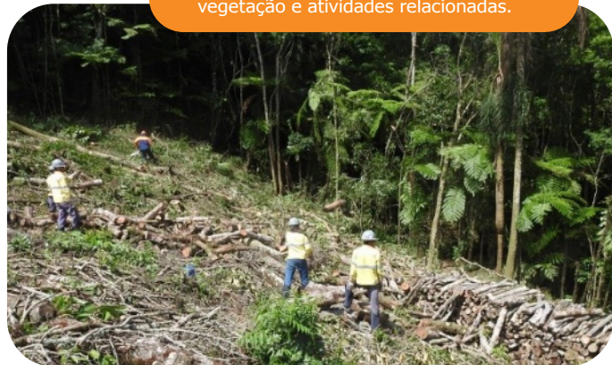
Execução da supressão de vegetação e atividades relacionadas.
