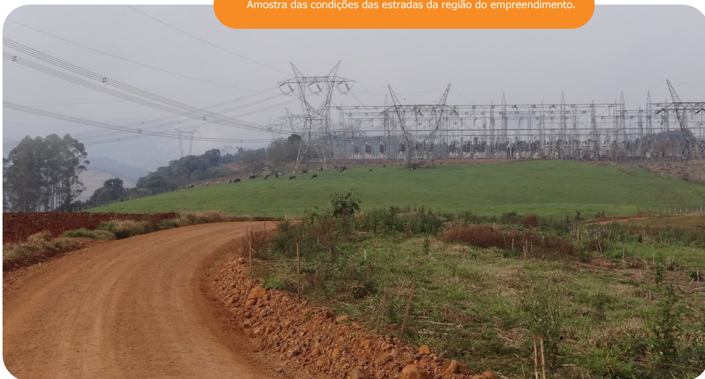
Amostra das condições das estradas da região do empreendimento.
