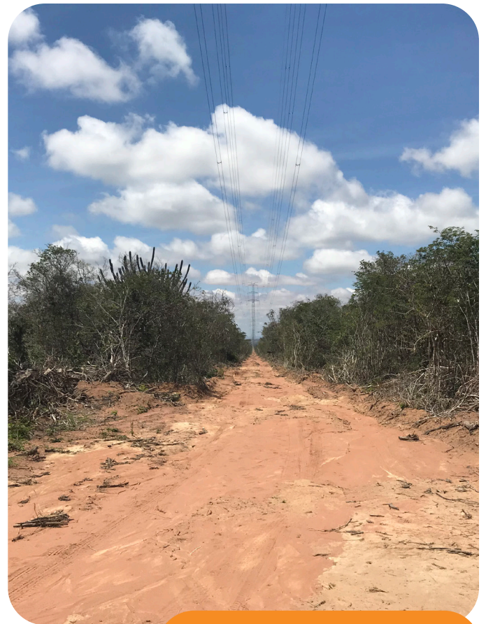
Faixa de serviço utilizada para lançamento de cabos e também como acesso de veículos.
