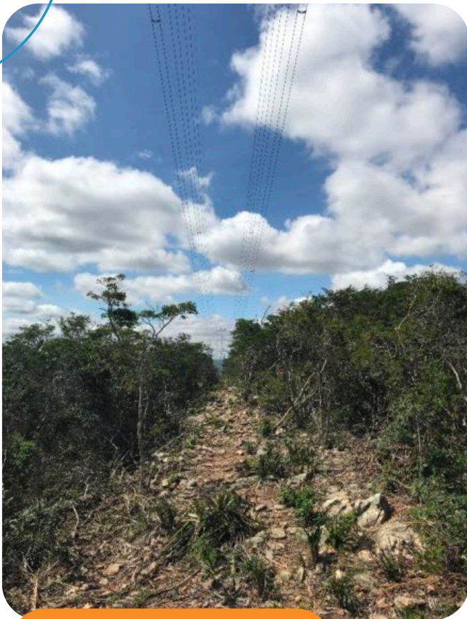
Faixa de serviço utilizada somente para o lançamento de cabos.
