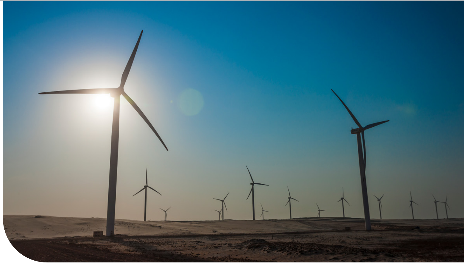
CPFL Renováveis wind farm
