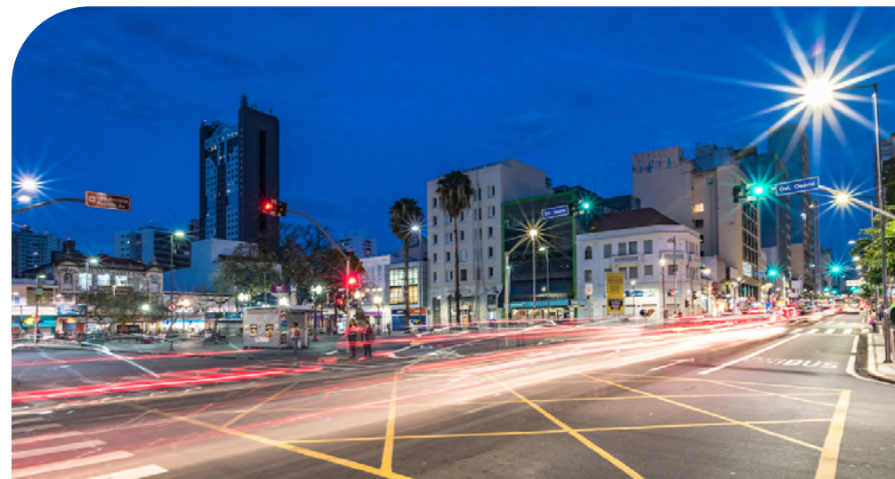
Avenida com rede subterrânea em Campinas (SP)
