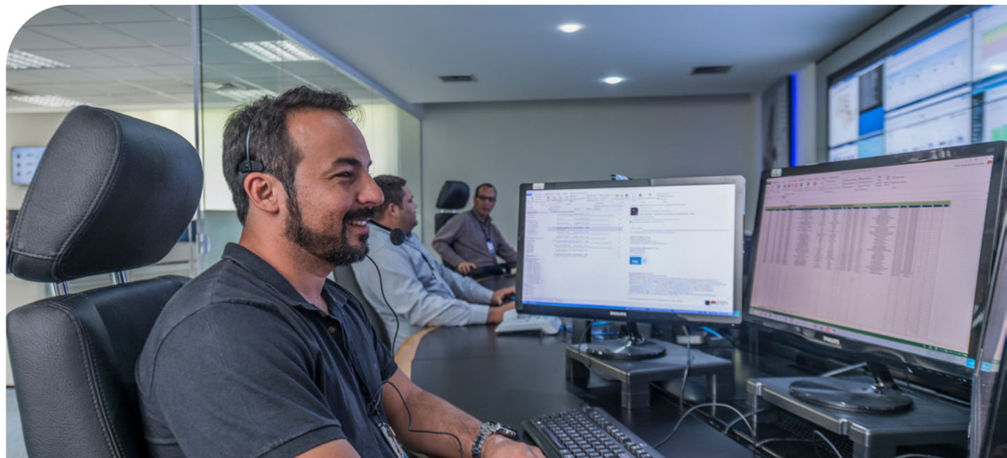
Centro de Operações de Telecom em Campinas (SP)
