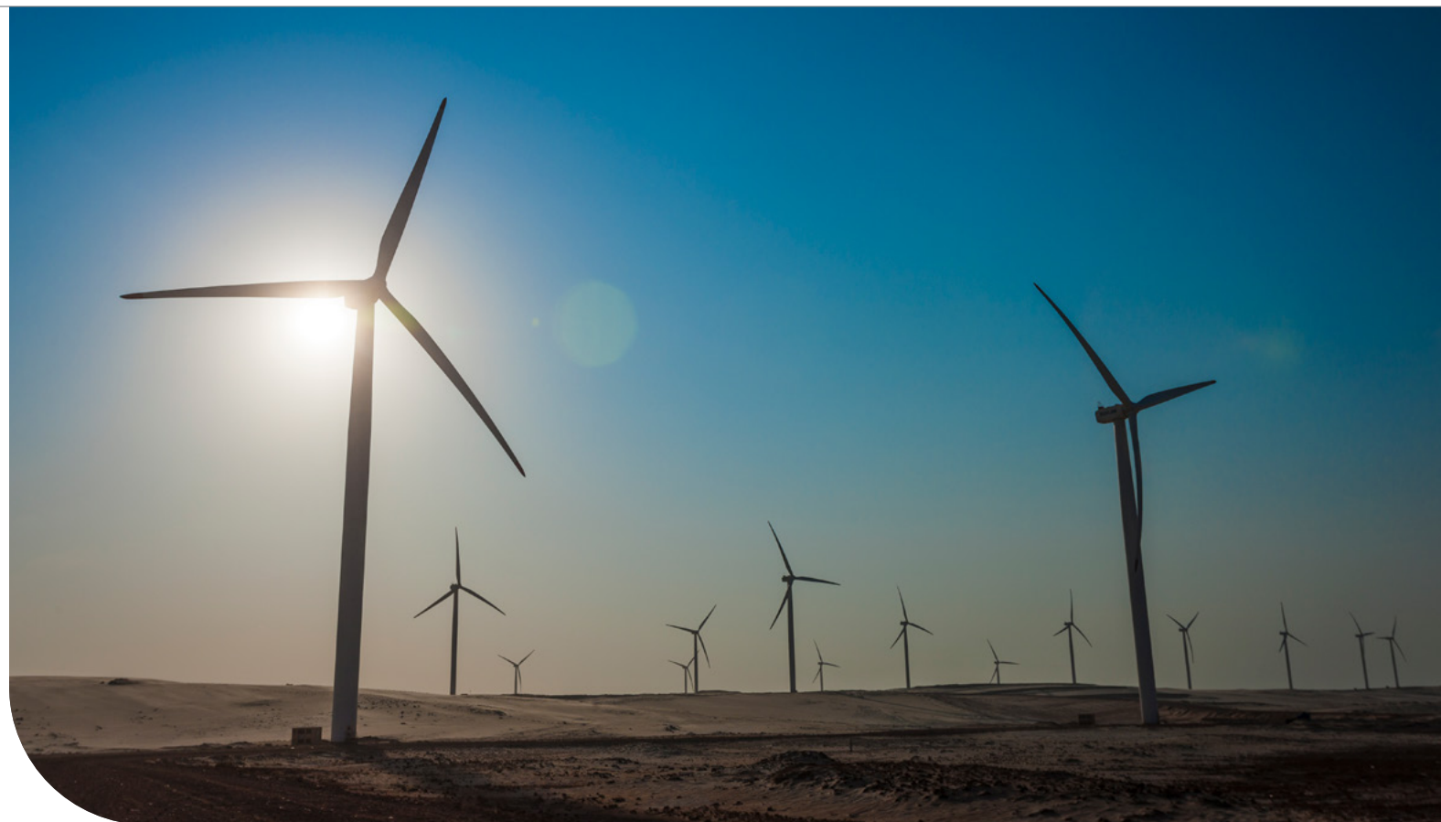
Complexo eólico da CPFL Renováveis
